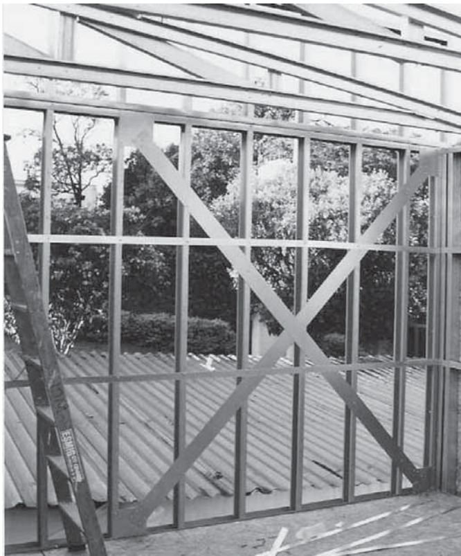
Foto 3.4 - Painel com contraventamento em "X" (fonte: arquivo do autor)
