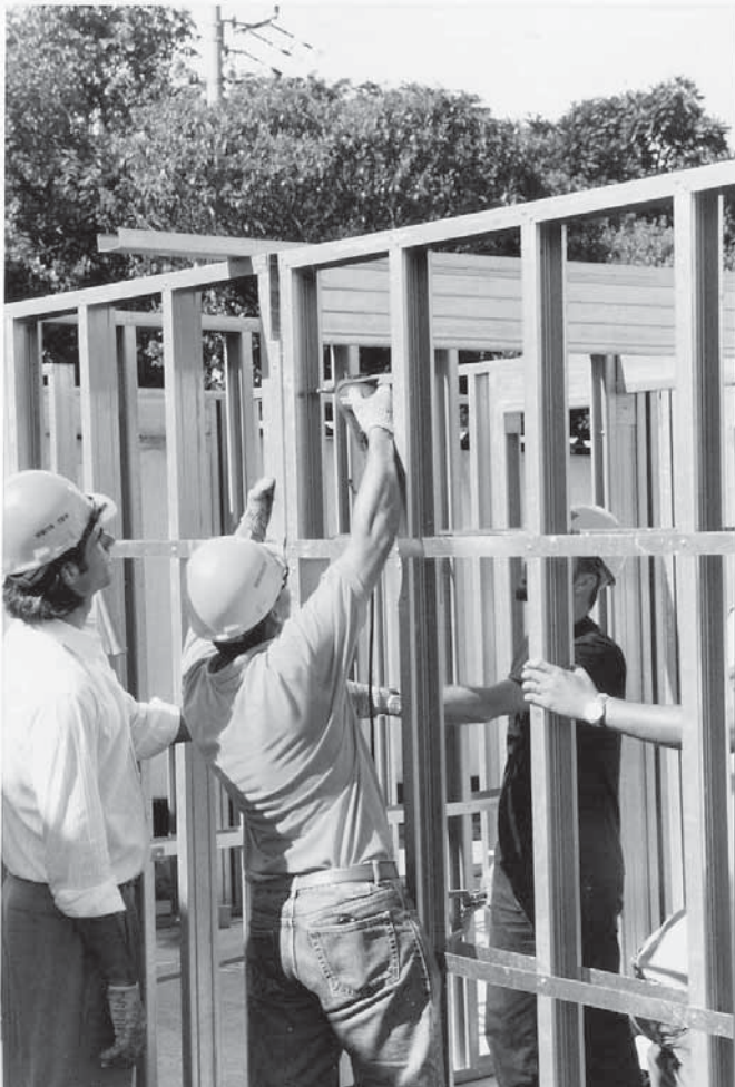
Foto 7.12 – Fixação de dois painéis com parafusos estruturais. (Fonte: arquivo do autor)
