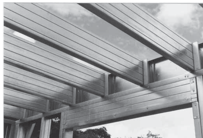
Foto 4.1- Vigas de piso (Fonte: arquivo do autor)
