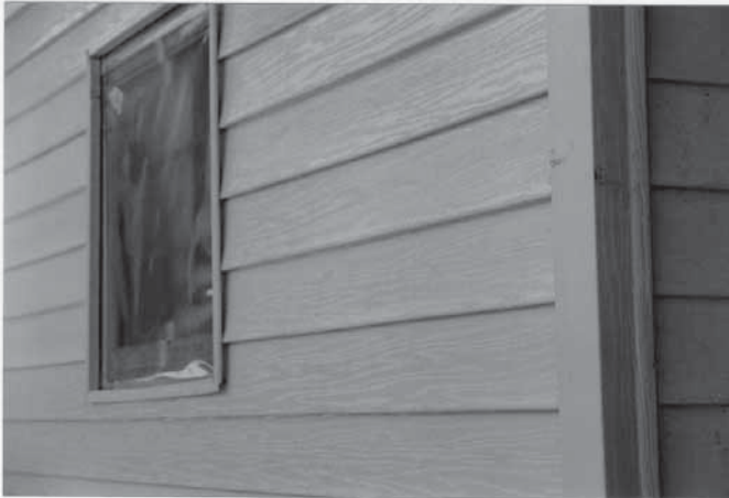
Foto 6.6 - Perfis acessórios para instalação do "siding" vinílico, no detalhe acabamento para esquadrias e cantoneiras. (Fonte: arquivo do autor)
