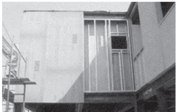
Foto 6.10 – Fechamento com placas cimentícias. (Fonte: Revista Techné nº 79)
