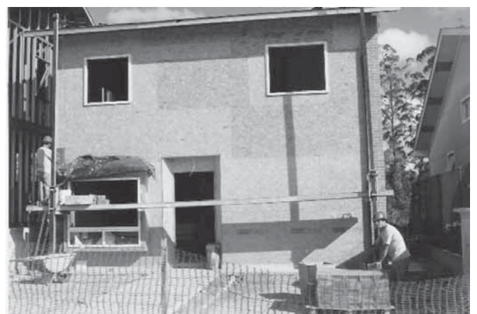
Foto 3.8 - Fechamento de fachada com placas de OSB. (fonte: arquivo do autor)
