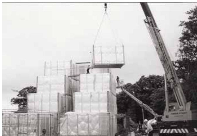
Foto 2.27 – Unidades modulares empilhadas na forma da construção final, o vazio que se vê ao centro formará a circulação de acesso às unidades. (Fonte: SCI)
