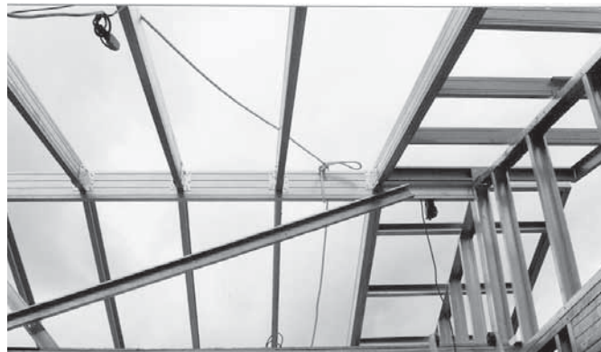
Foto 5.3 - Cumeeira composta de perfis U e Ue para apoio dos caibros (Fonte:arquivo do autor)
