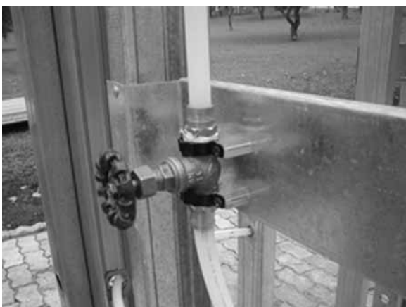
Figura 8.5 – Registro fixado sobre peça metálica auxiliar Fonte: SANTIAGO, TERNI, PIANHERI, 2008b
