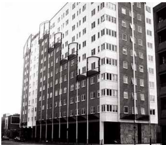
Foto 2.22 - Reforma de fachada usando Light Steel Framing. (Fonte: disponível em: http://www.steel-sci.org/lightsteel )
