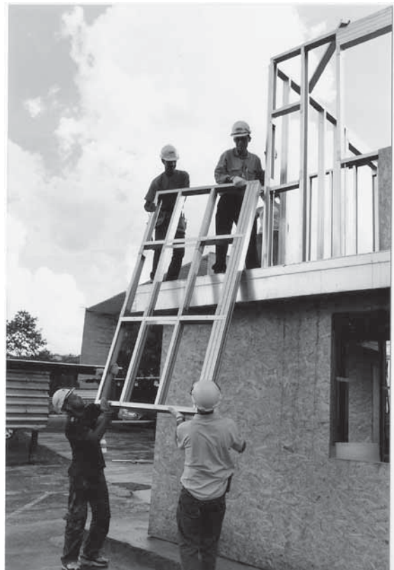
Foto 7.17 – Montagem dos painéis do pavimento superior. (Fonte: arquivo do autor)
