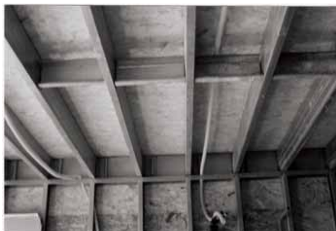
Foto 2.7 - Vista da estrutura do piso com vigas em perfis galvanizados e contrapiso em OSB. (Fonte: arquivo do autor)
