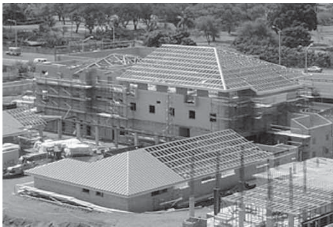
Foto 5.12 -Telhas de aço usadas na cobertura da edificação.(Fonte: http://www.aegismetalframing.com ).
