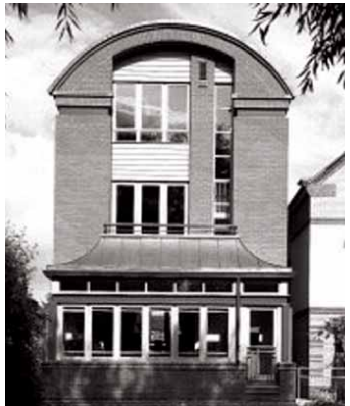
Foto 2.12 - Residência em Oxford – Inglaterra (Fonte: disponível: http://www.steel-sci.org/lightsteel/ )
