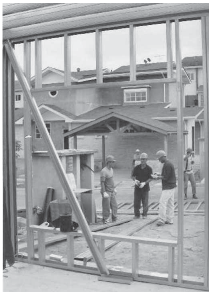
Foto 3.10 - Painel não-estrutural de fachada de residência. (Fonte: arquivo do autor)
