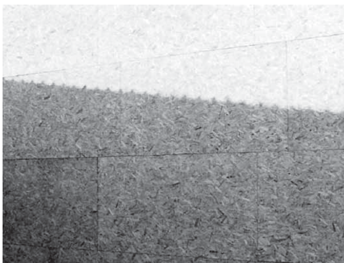
Foto 6.4- Instalação de OSB na fachada com juntas verticais defasadas. (Fonte: arquivo do autor)
