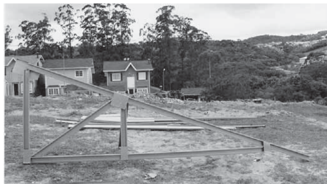
Foto 5.8 - Tesoura em "meia água" cujos elementos estão fixados em placas metálicas de aço (placas de Gusset). (Fonte: arquivo do autor)
