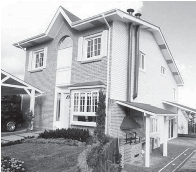
Foto 6.9 - Fachada revestida com tijolos maciços aparentes. (Fonte: Disponível em: http://www.construtorasequencia.com.br )
