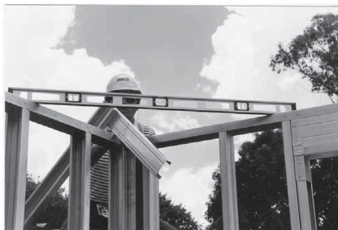
Foto 7.9 – Verificação do nível do painel e fixação da ancoragem. (Fonte: arquivo do autor)
