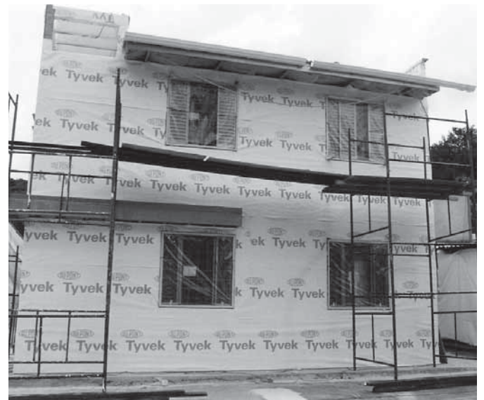
Foto 6.3- Impermeabilização das placas de OSB da fachada da foto anterior com membrana de polietileno. (Fonte: arquivo do autor)
