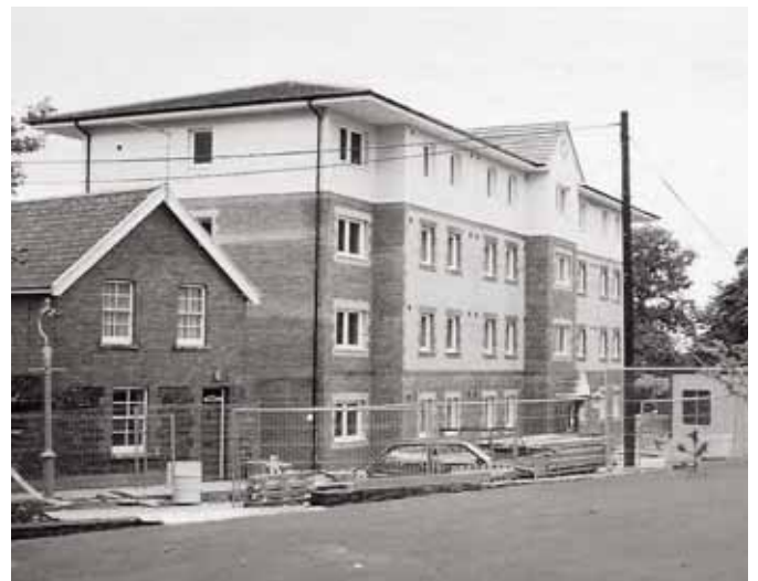
Foto 2.16 - Edifício na Inglaterra. (Fonte: SCI)
