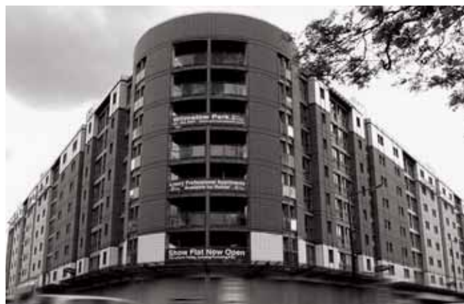
Foto 2.20 - 1.425 módulos em LSF formam esse edifício na Inglaterra. (Fonte: disponível em: http://www.corusconstruction.com/page_9088.htm ).
