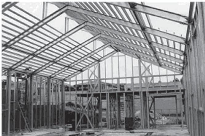
Foto 5.2 – Telhado estruturado com caibros em um Laboratório na Universidade Federal de Ouro Preto – MG (Fonte: arquivo Célio Firmo)
