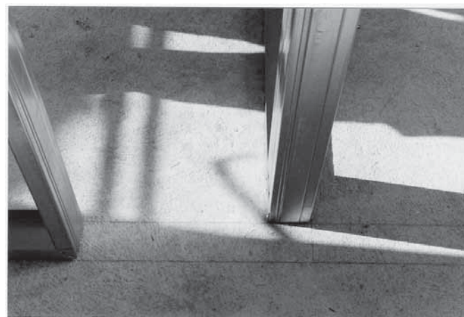
Foto 7.11 – Marcação da localização dos painéis internos. (Fonte: arquivo do autor)
