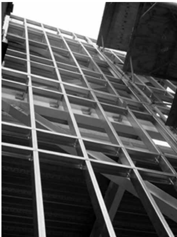
Figura 9.1 – Fechamento externo em Light Steel Framing Fonte: Acervo Flasan, 2011
