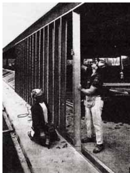
Foto 2.25-Light Steel framing montado pelo método "stick" (Fonte: Robert Scharff).
