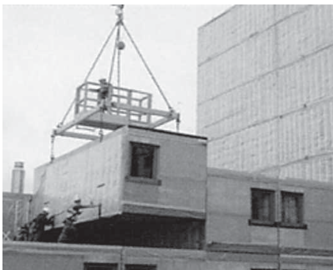
Foto 7.2- Unidades modulares sendo posicionadas na construção (Fonte: disponível em: http://www.corusconstruction.com/page_9088.htm )
