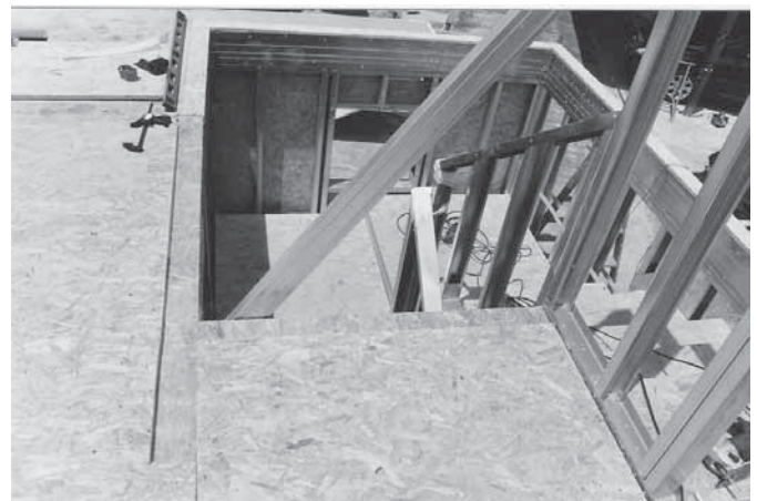
Foto 4.4 - Placas de OSB utilizadas para laje seca. (Fonte: arquivo do autor)
