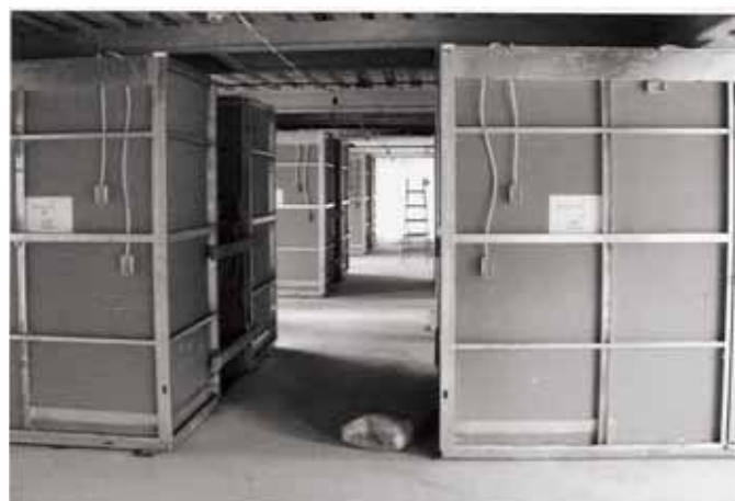
Foto 2.21 - Módulos de banheiros prontos e posicionados no Hotel Mondial Airport Business em São Paulo. (Fonte: Zigurate Editora) 2
