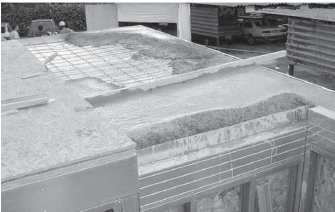
Foto 7.16 – Execução de laje úmida. (Fonte: Usiminas)
