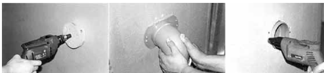
Figura 8.10 – Instalação de joelho com flange Fonte: Tigre, 2010
