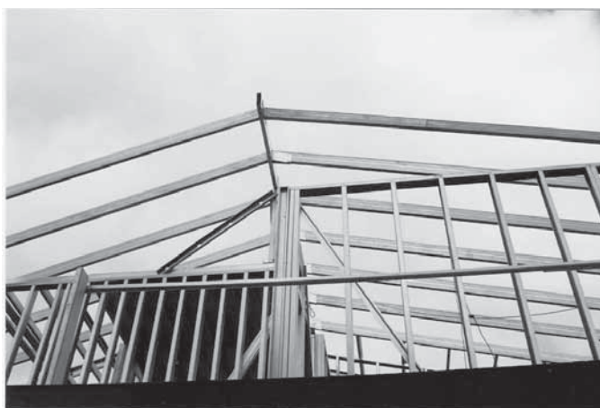
Foto 7.20 – Montagem de tesouras de telhado. (Fonte: Disponível em: http://www.consulsteel.com/cas/default.asp )
