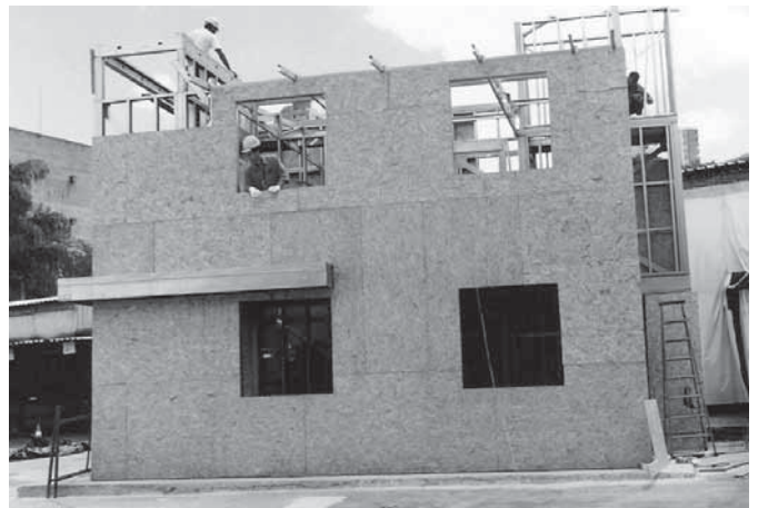
Foto 7.14 – Juntas de placas devem estar defasadas. (Fonte: arquivo do autor)
