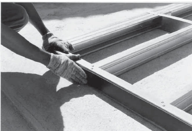
Foto 7.5 – Aplicação de fita selante na base do painel. (Fonte: arquivo do autor)
