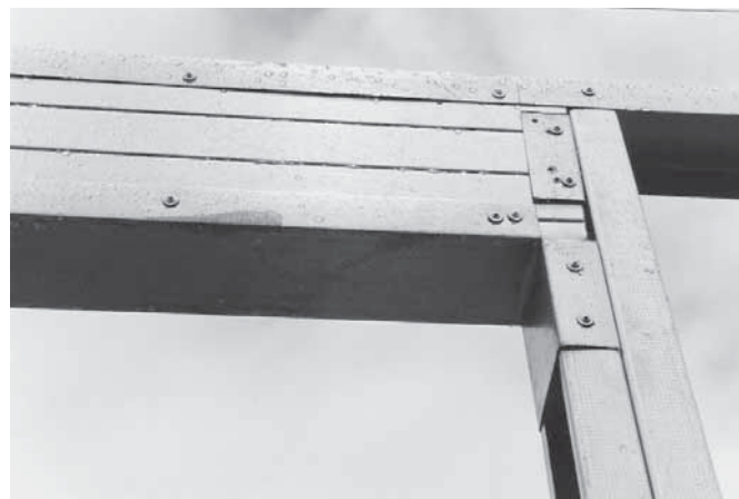
Foto 3.3 – Detalhe de verga para abertura de janela. (Fonte: arquivo do autor)
