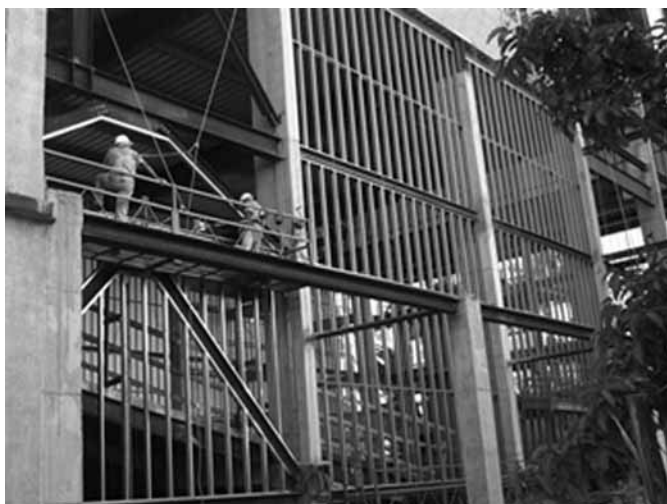
Figura 9.2 – Fechamento externo em Light Steel Framing Fonte: Acervo Flasan, 2011
