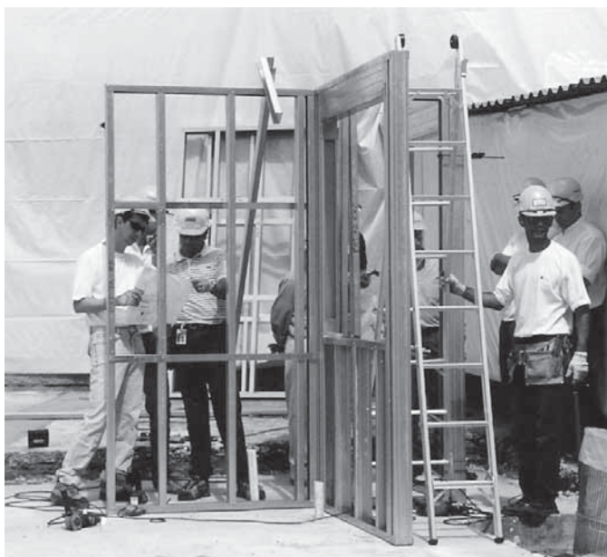
Foto 7.8 – Montagem dos painéis. (Fonte: arquivo do autor)
