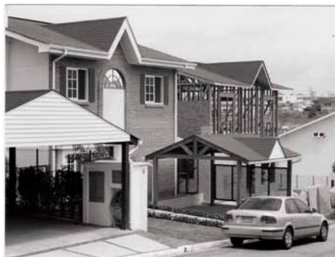
Foto 2.9 - Residências construídas com o sistema Light Steel Framing em Cotia - São Paulo. (Fonte: Arquivo do autor)
