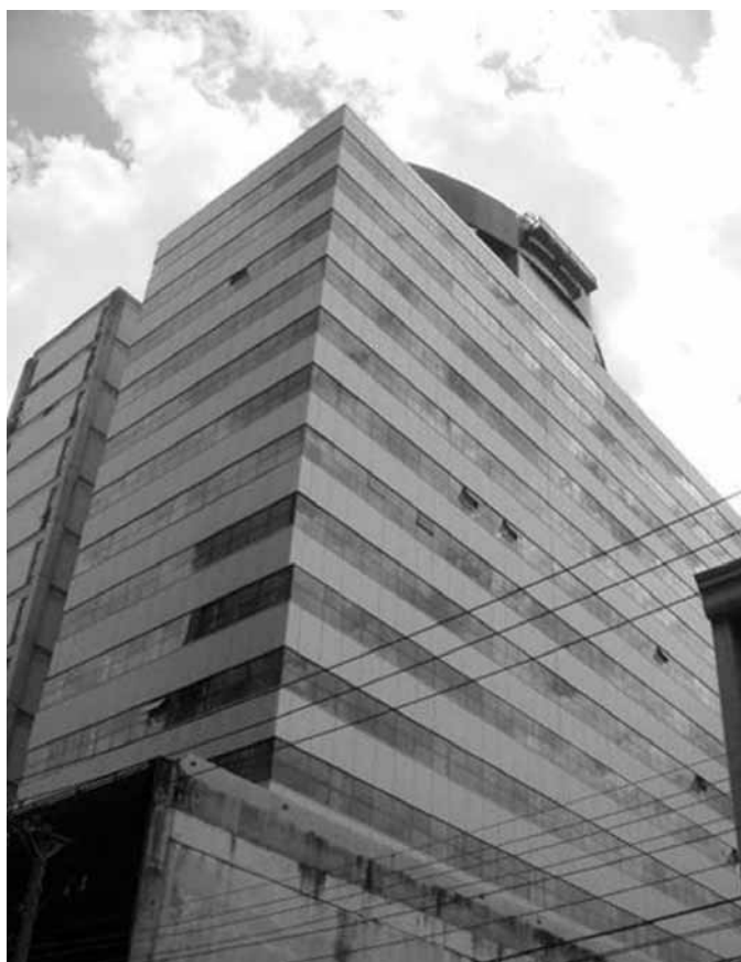
Figura 9.32 – Edifício com fachada estruturada em Light Steel Framing e revestida com painéis metálicos
