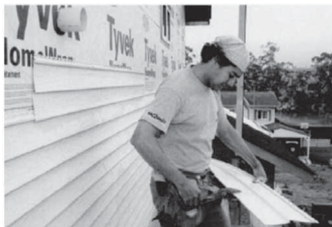
Foto 6.5 Instalação de siding vinílico. (Fonte: Marcos Lima 1 )
