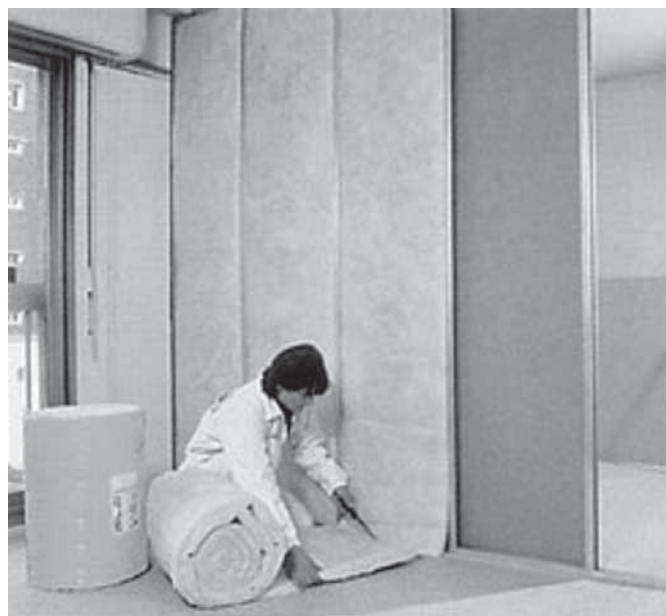
Foto 6.11 – Instalação de lã de vidro em painel
