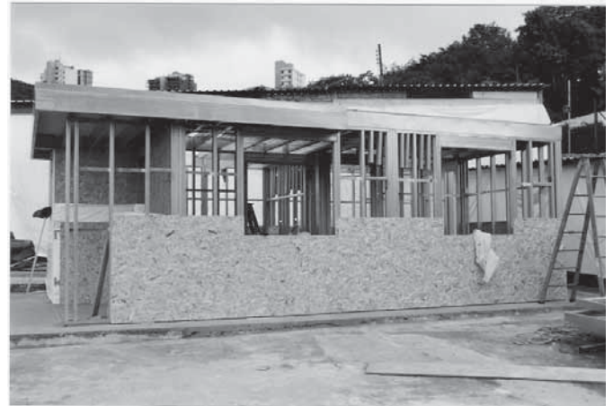
Foto 7.13- Colocação do fechamento externo dos painéis. (Fonte: arquivo do autor)
