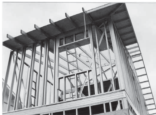
Foto 5.4 - Placas de OSB para fixação de telhas “shingles” (Fonte: arquivo do autor)
