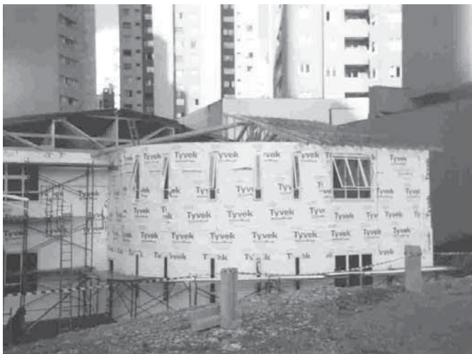
Foto 3.11 – Montagem de paredes curvas projetadas para construção com perfis formados a frio em um ambulatório em Curitiba. (Fonte: US Home)
