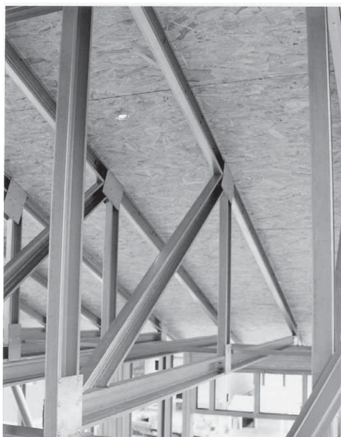
Foto 5.10 - Placas de OSB para fixação de telhas “shingles” (Fonte: arquivo do autor).
