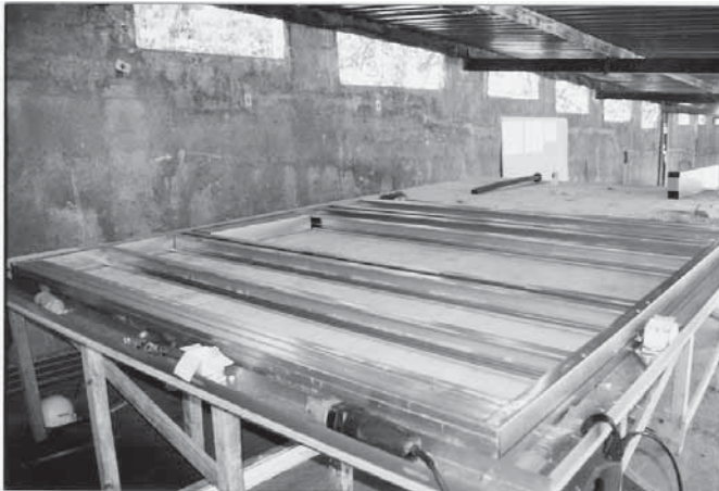
Foto 7.4 – Mesa de trabalho para montagem de componentes estruturais. (Fonte: arquivo do autor)
