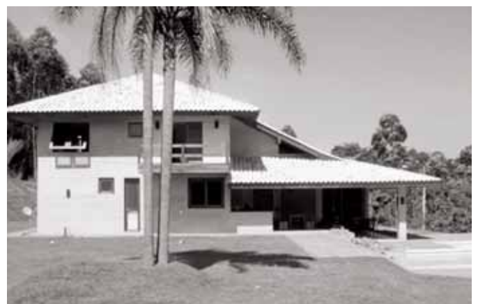
Foto 2.13 - Residência em São Paulo. (Fonte: disponível em: http://www.construtorasequencia.com.br )
