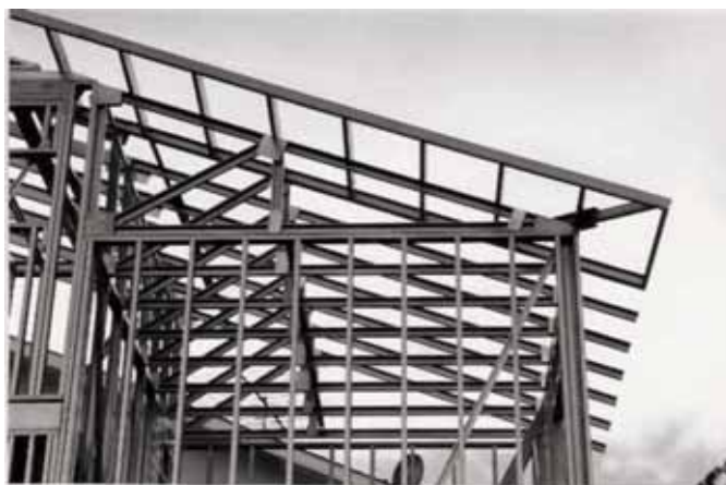
Foto 2.8 - Estrutura do telhado de residência em Light Steel Framing. (Fonte: Arquivo do autor)
