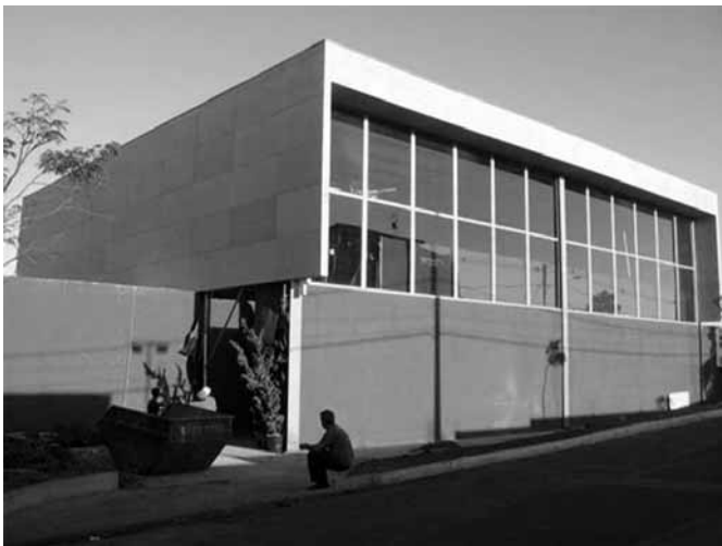
Figura 26 – Fechamento com placas cimentícias com juntas visíveis / Fonte: Acervo Flasan, 2011
