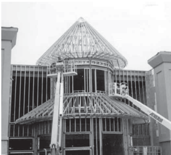
Foto 5.5 - Modelo de tesoura de telhado confeccionada com perfis de aço formados a frio galvanizados. (Fonte: http://www.aegismetalframing.com ).
