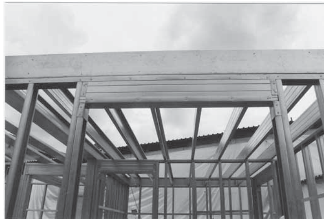
Foto 4.6 - Vigas de piso apoiadas em montantes de painéis do pavimento térreo (Fonte:arquivo do autor)
