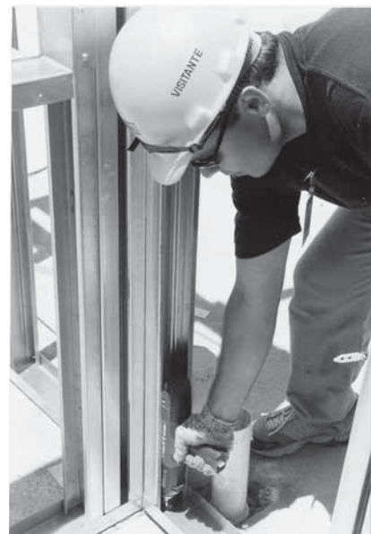
Foto 7.7 – Ancoragem provisória com pinos de aço. (Fonte: arquivo do autor)
