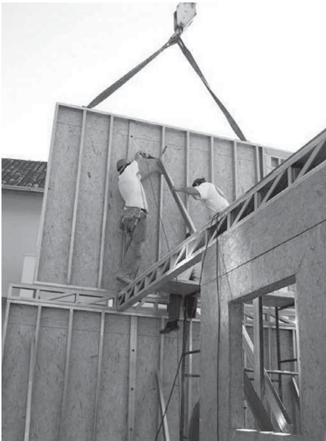
Foto 7.18 – Içamento e posicionamento de painel de pavimento superior. (Fonte: disponível em: http://www.lds.com.br/steelframe/montagem_023_gr.jpg )
