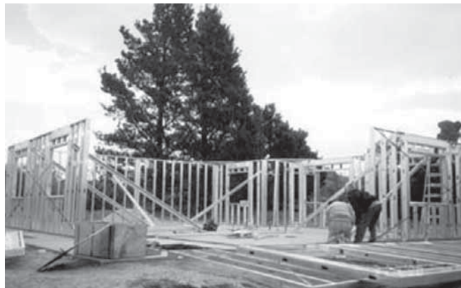
Foto 7.10 – Montagem dos painéis externos (Fonte: Disponível em: http://www.consulsteel.com/cas/default.asp )
