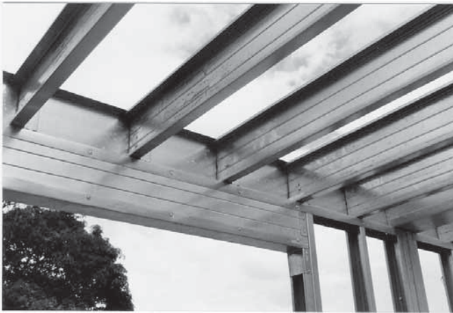
Foto 7.15 – Posicionamento das vigas de piso na sanefa. (Fonte: arquivo do autor)
