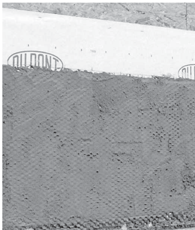
Foto 6.7 - Revestimento das placas de OSB com argamassa aplicada sobre tela tipo “deployée”. (Fonte: arquivo do autor)
