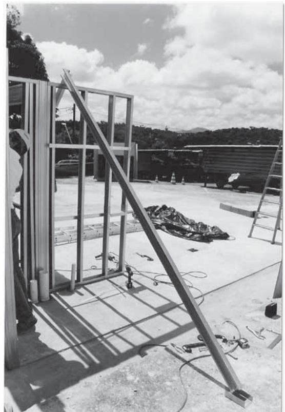
Foto 7.6 – Escoramento do painel durante a montagem. (Fonte: arquivo do autor)
