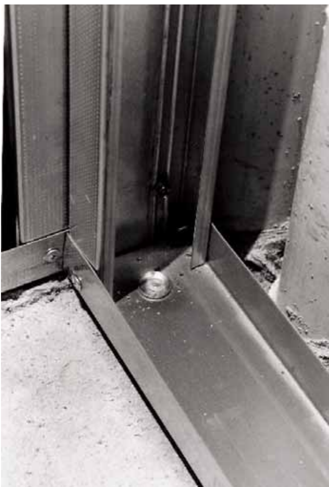
Foto 2.32 – Ancoragem provisória. (Fonte: arquivo do autor)
