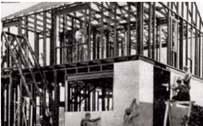
Foto 2.3 - Protótipo de residência em Light Steel Framing na Exposição Mundial de Chicago em 1933 (Fonte: disponível em: http://webpages.marshall.edu/~brooks/STRAN/stran1.htm )
