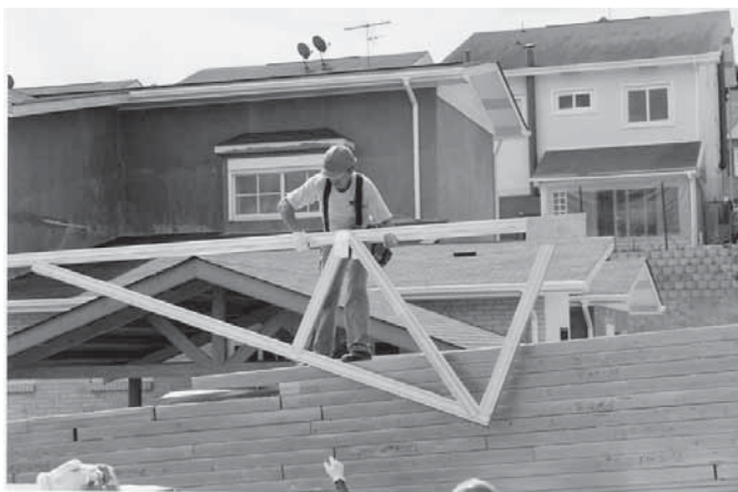
Foto 5.7 - Tesoura de telhado sendo descarregada no canteiro de obras. (Fonte: arquivo do autor)
